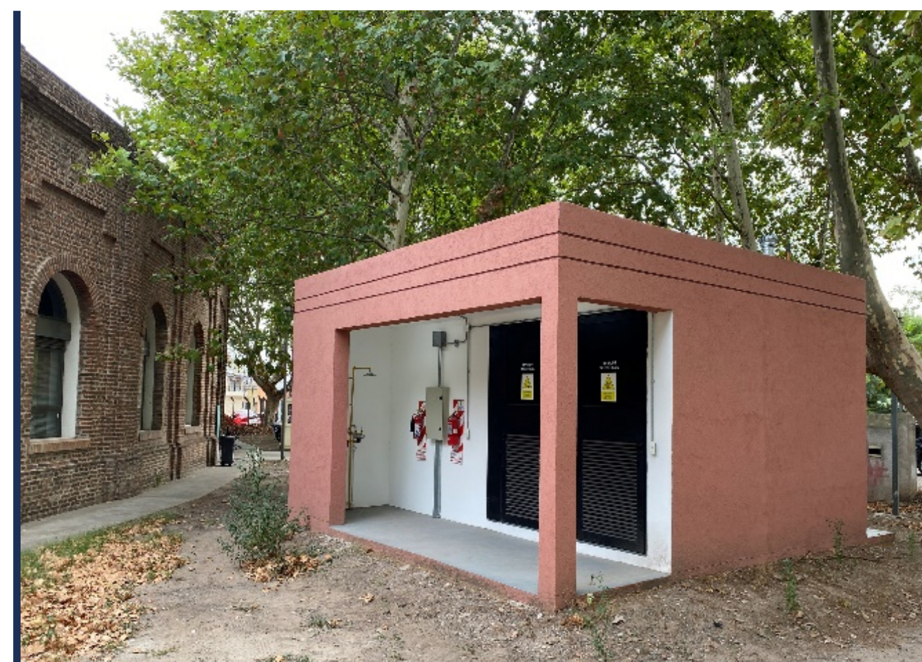
CUARTO DE RESIDUOS CRE OBRA NUEVA 40 M 2
